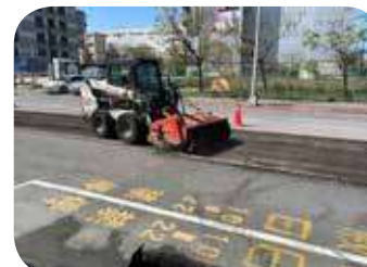
道路 AC 修復
