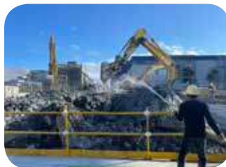
工地揚塵灑水
