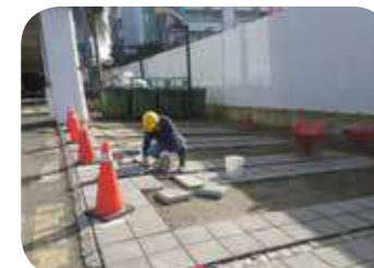
鄰房鋪面修復
