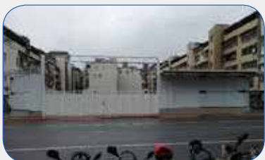
日式拉門及安全走廊組立
