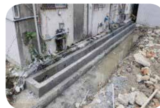
鄰房侵界水溝協助重製
