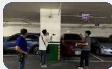
鄰房結構現況鑑定 (1)
