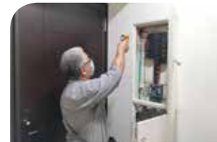
機電：盤內所有接點溫度量測有無異常高溫
