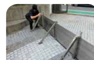
公設：防水閘門安裝演練
