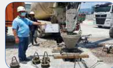
混凝土澆置查驗
