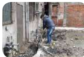
既有水溝定期清淤
