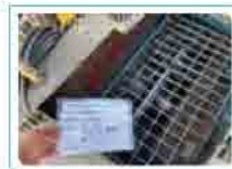
■ 澆置前壓送車槽體檢查
