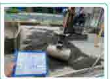
■ 透水鋪面之透水混凝土澆置
