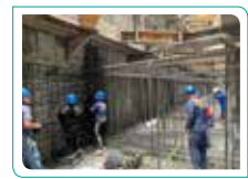
■ FS 版及地樑鋼筋綁紮
