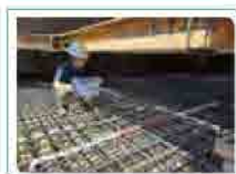
■ 樑版鋼筋綁紮查驗
