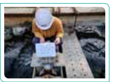
■ 土壓計壓力數值檢核
