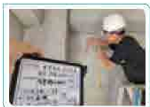
■ 冷氣排水測試查驗
