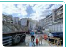
■ 工地內揚塵灑水
