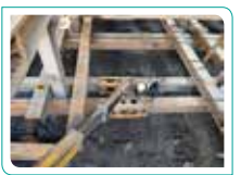
■ 土壓計護蓋吊放
