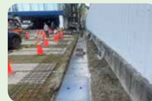
■ 鄰房水溝修繕
