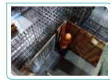
■ 地樑側模模板組立
