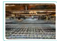
■ 樑版鋼筋綁紮
