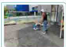
■ 透水鋪面之透水混凝土夯實
