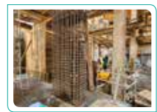
■ 柱牆鋼筋綁紮
