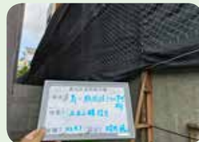
■ 圍籬加高 (防止外人入侵鄰房)
