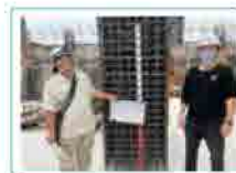
■ 業主查驗柱牆鋼筋
