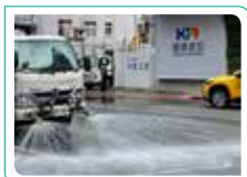
■ 工地外定期清潔
