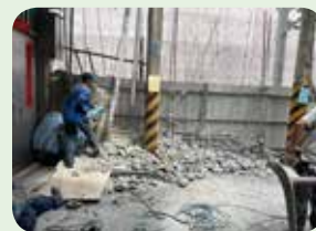
■ 鄰房危牆協助打除
